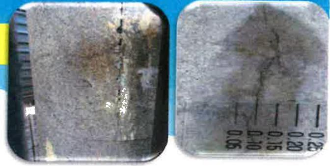
コンクリートポールは適切な管理を行えば数十年はもつと言われていました。しかし、台風などの強風や塩害、不平衡な荷重によるストレスなど、様々な要因で経年とともに劣化が進むことが知られています。劣化が進むと、倒壊や折損等でポールとしての機能が失われるばかりか、最悪の場合、人命に関わるリスクもあります。
